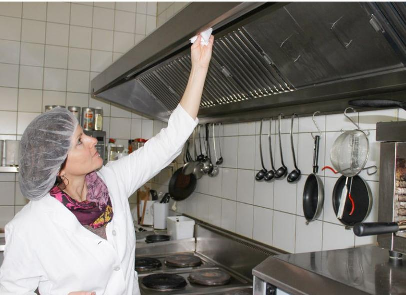
**Abb. 2: Lebensmittelkontrolleurin prüft Reinigungszustand einer Abluftanlage**
